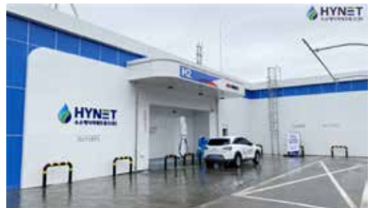
내린천휴게소(양양방향)에 위치한 하이넷 수소충전소 외경
