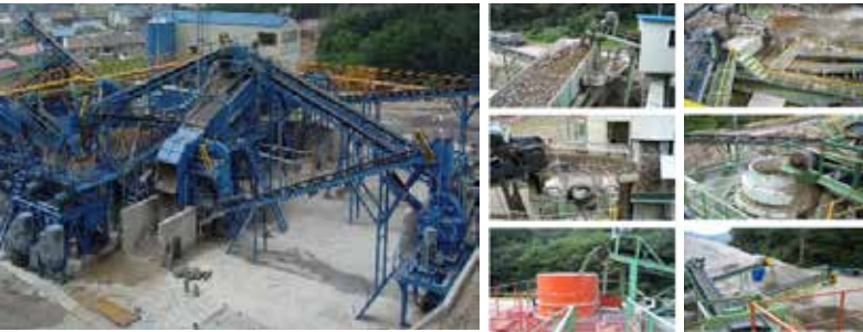
그림2. 순환골재 생산시설 전경 등
